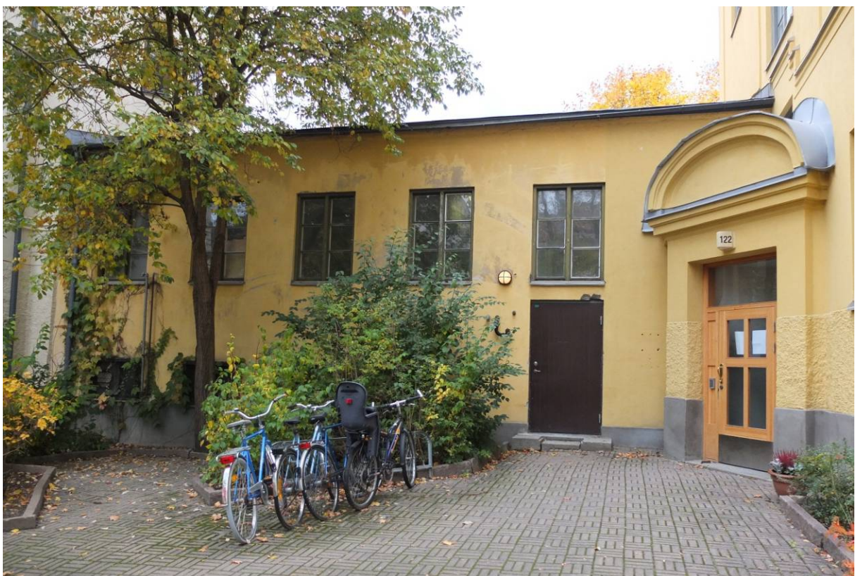
Fasad mot Hägerstensvägen. Foto: Fredrika Mellander Rönn.
