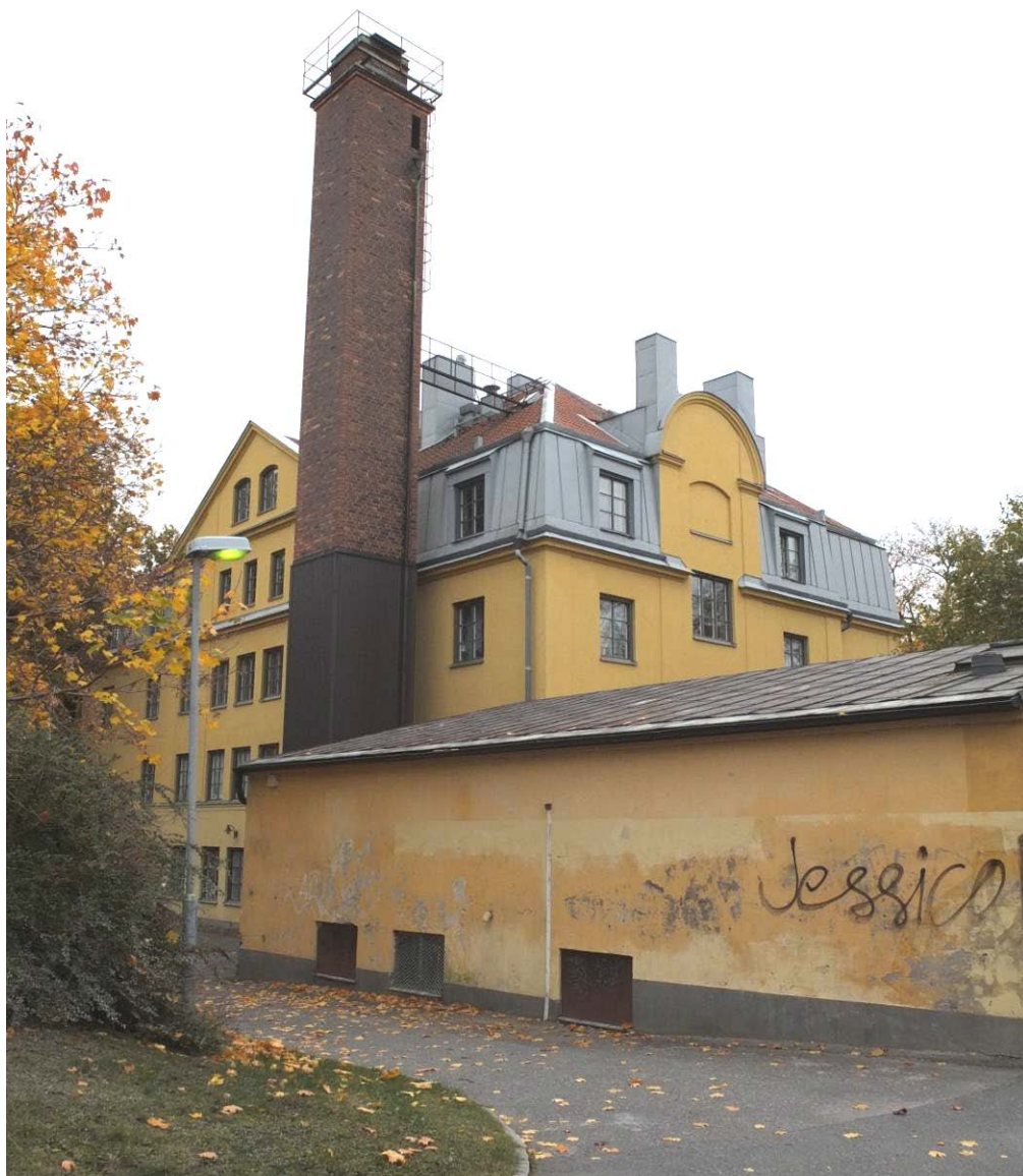
Panncentralen bakre fasad med skorsten och luckor ner till källarplanets pannor. Foto: Fredrika Mellander Rönn
