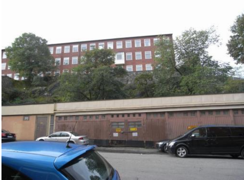
Garagebyggnaden nedanför bergskärningen på Dannemoragatan
