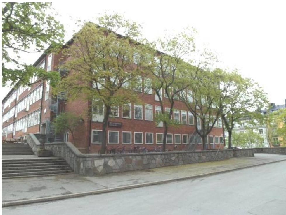
Rödabergsskolan huvudbyggnad uppfördes 1953 och är grönklassad enligt Stockholms stadsmuseum
