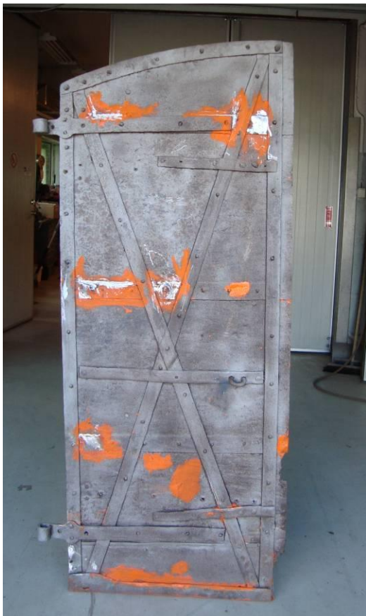
Portarnas utsidor efter renblästring och lagning med bly. Foto: Z-metallform 2013
