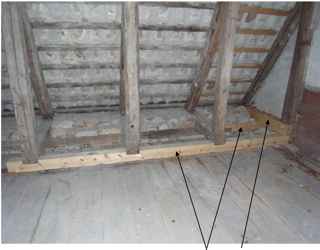
Takstolar mot södra fasaden där rötskadade delar bytts ut (remstycken och tass). Gammalt tegel är understruket.
