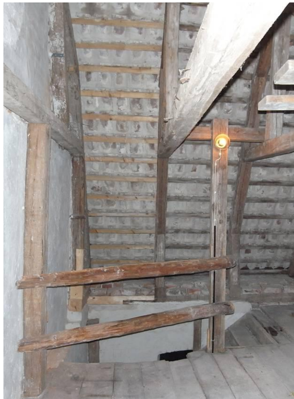
Ny räcketolpe med armatur på har monterats och fixerats i takstolens hanbjälkar.
