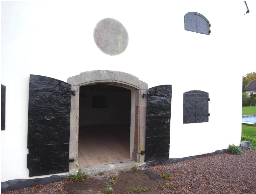
Entrén mot öster. Portarna är konserverade av Z-metallform AB.
