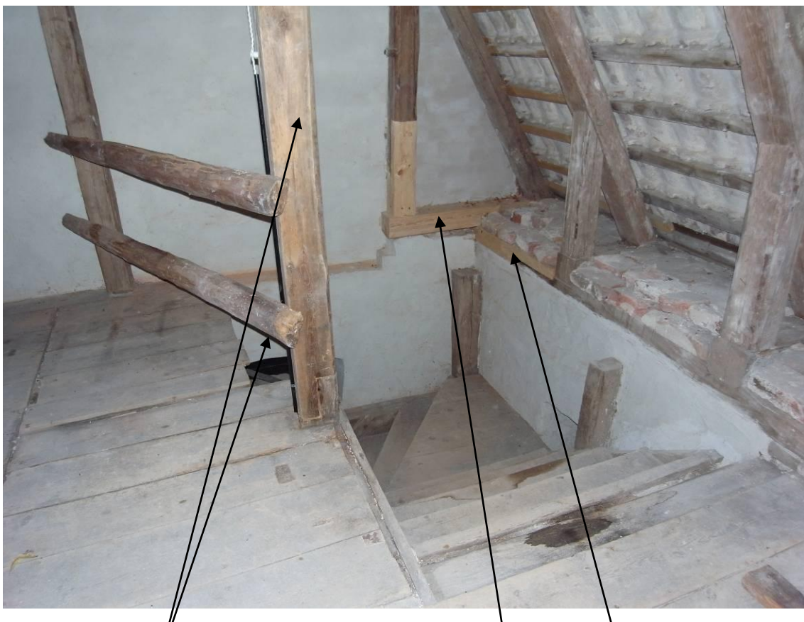
Takstol mot södra fasaden där rötskadade delar bytts ut (stödben, tass och remstycke) samt ny räckestolpe och avbärare.
