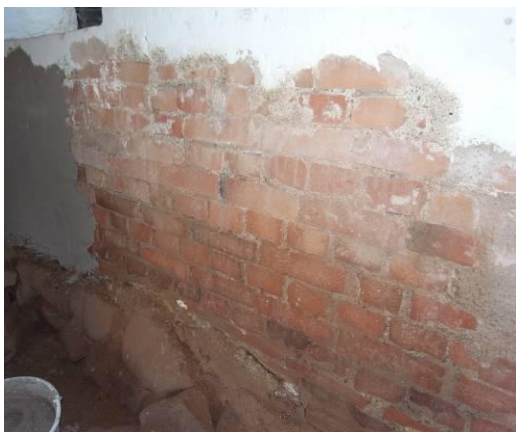
Entréväningens södra och västra väggar hade oljebemängd puts. Ytor har blästrats och fogar rensats. Ny kalkputs har påförts
