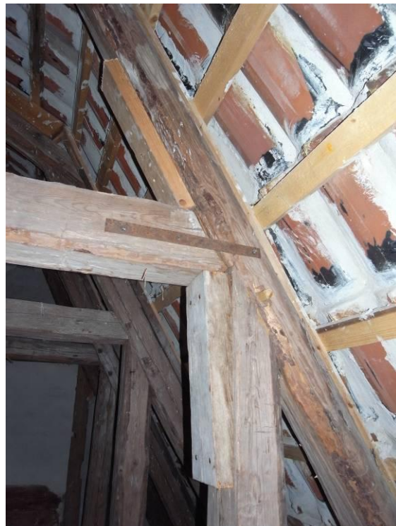
Hanbjälskens infästning med tapp och sprint har ersatts med ett underliggande stöd och dragjärn
