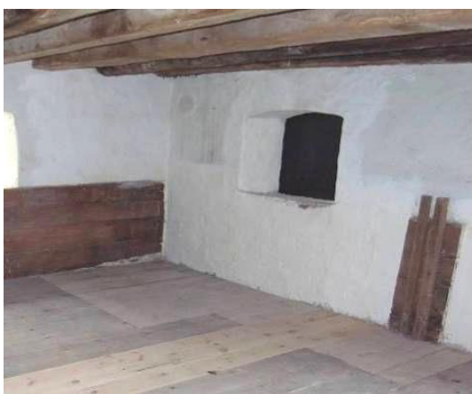
På våning 1tr har sädesbingarnas väggbeklädnader rivits på norra och delar av östra väggen. ytorna har ersatts med avfärgad puts
