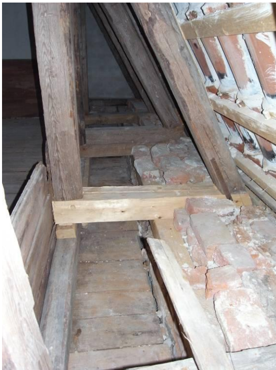
Remstycke och taktass utbytta på takfall mot norr.
