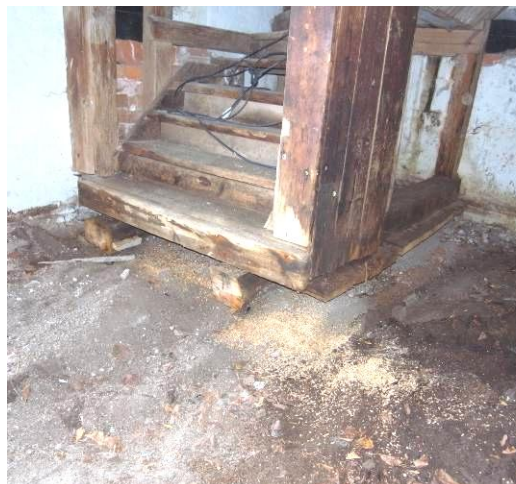
Bjälkar och golv sparade under trappan
