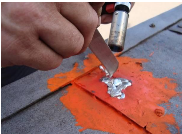
Rosthål fylls igen med bly. Foto: Z-metallform 2013.
