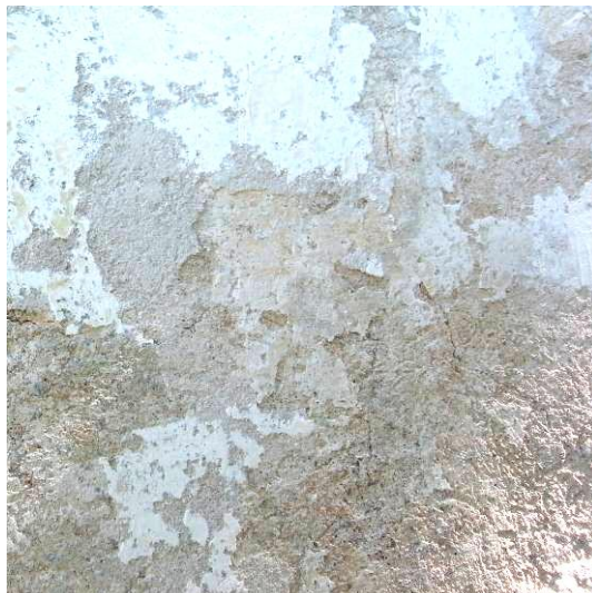
Bevarade putslager har även spår av äldre avfärgningar i tre lager. Samtliga med pigmentering innehållande guldocker.
