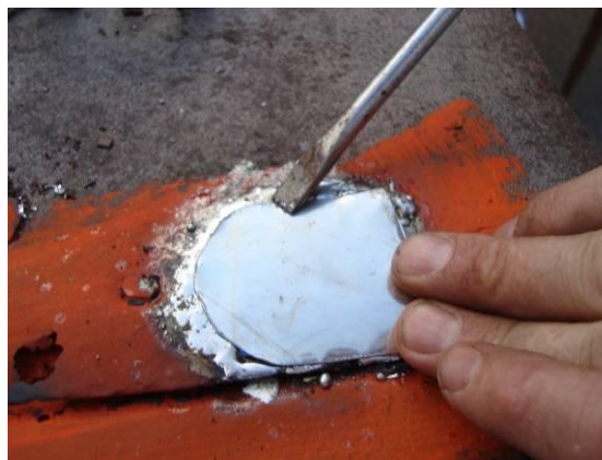
Lagning med plåt och fixering med bly. Foto: Z-metallform 2013
