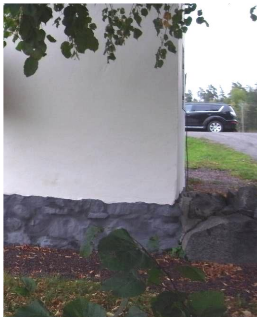
Samma hörna efter omputsning med sockelputsen ersatt av enbart fogstrykning och målade sockelstenar. Allt cementbruk är nu borta.
