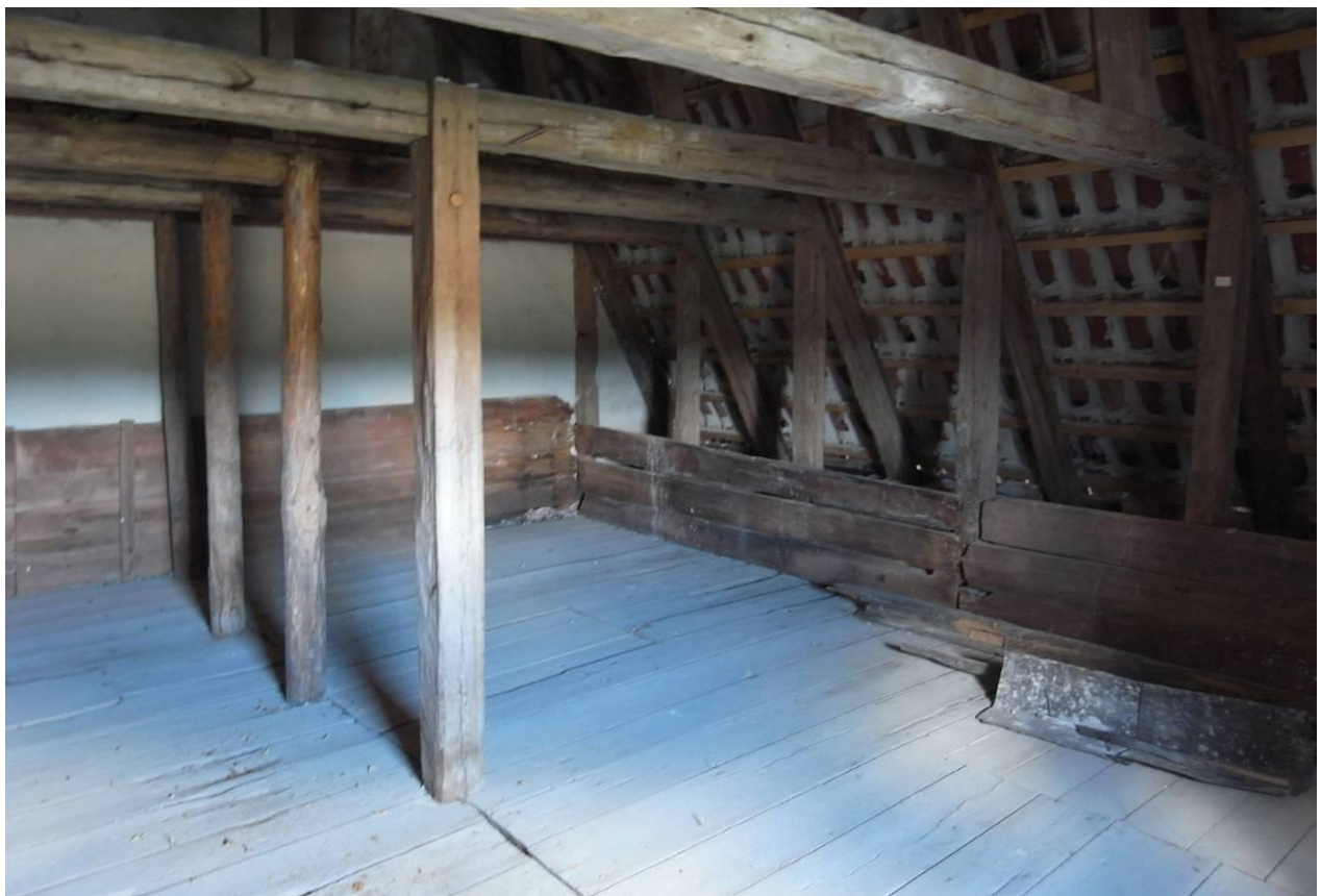
Vindsgolvet återlagt och infäst. Sädesbingarnas paneler rensade från rötskadat virke.
