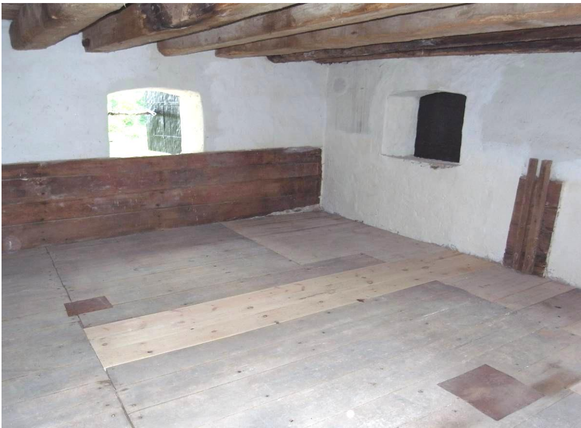
Tre golvplankor är nya och nya metalluckor lagda över sågade hål i golvet. Rötskadade väggbeklädnader till sädesbingarna har rivits och väggarna avfärgats.
