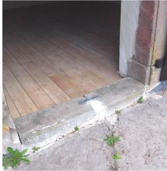
Befintliga tröskelstenar som fått nytt upplag och ny stålbygel och blygutning kring hålen.
