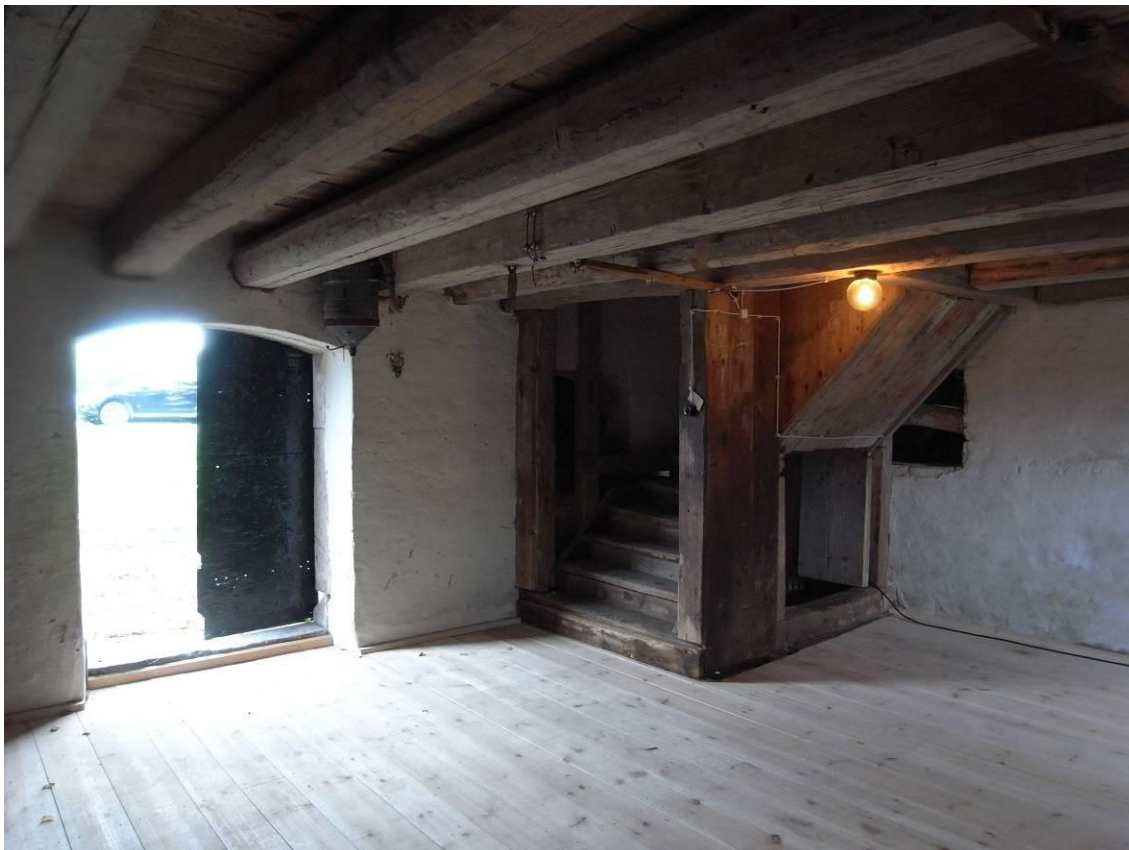
Entrén till Torsåkers magasin med nytt trägolv och kompletterad elinstallation
