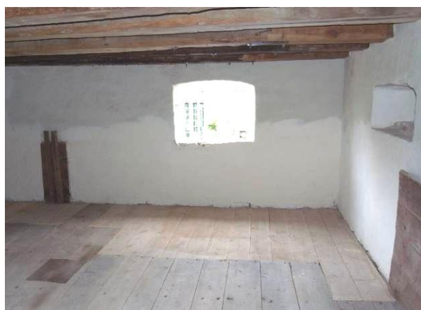
Putsen har här fått en ny yta på nedre delen av väggen medan sista strykningen över hela ytan kvarstår.
