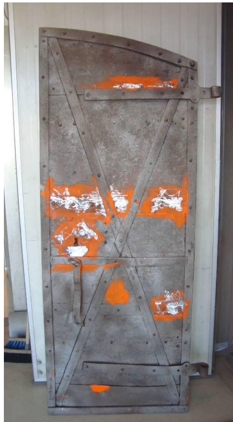
Före blygjutningen sker målning med blymönja. Foto: Z-metallform 2013
