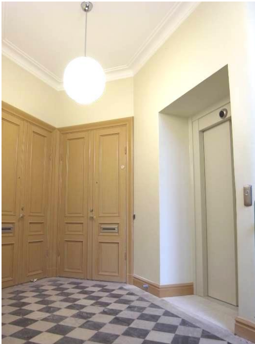
Vilplanen i gatuhuset med ny hissinstallation
