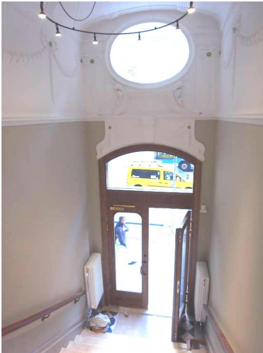
Ny ekport har monterats i entrén mot gatan och stuckaturena är bevarade i taket och på väggarnas övre delar.
