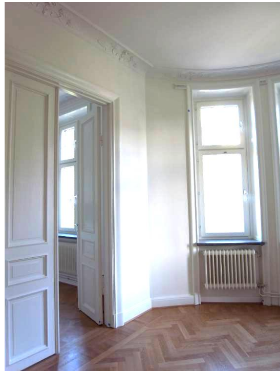
Pardörrar och smygsnickorer till fönstren är bevarade samt nya stuckaturer i taket.
