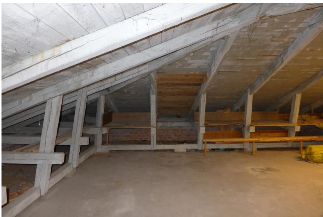
Överst: ursprungliga takkupor mot gård. Ovan: takstolar och del av vinden åt norr
