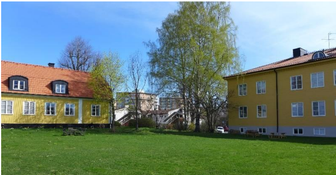
Överst: Gårdssidan av kontorsbyggnaden. Ovan: mötet mellan kontorsbyggnaden och bostadsbyggnaden.
