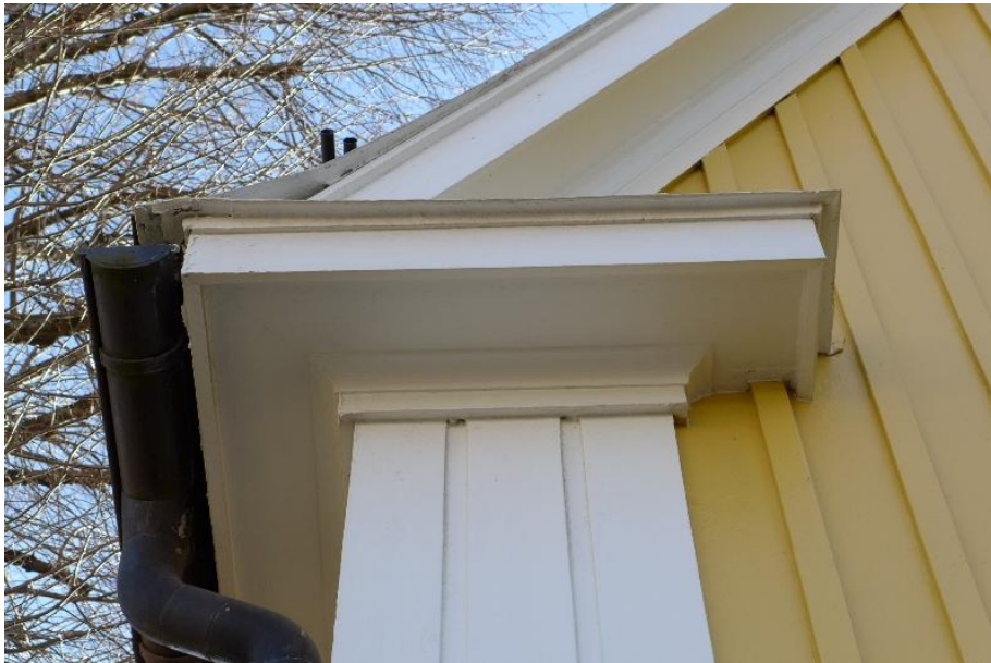
Överst till vänster: gavel mot öst. Överst till höger: detalj fasad. Ovan: hörnpilaster och gesims
