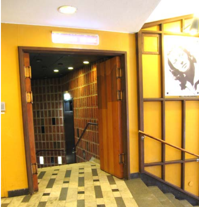
Entrén till nedre foajén i f.d. högra rampen
