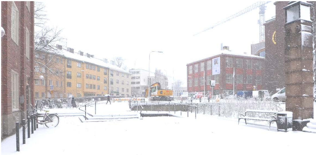
Anpassning av marken och ny trappa vid norra gavelfasaden
