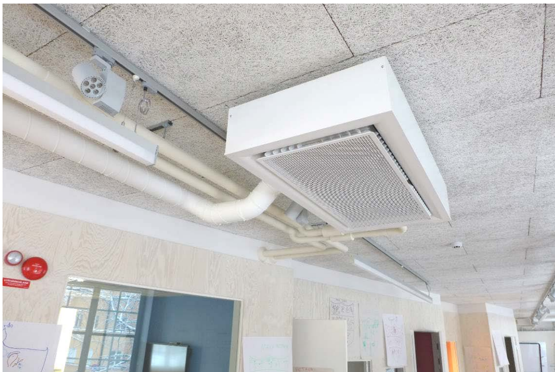
Open lab plan 3, Tekniken är synlig med akustiska dämpningen mot stommen för att vinna takhöjd.
