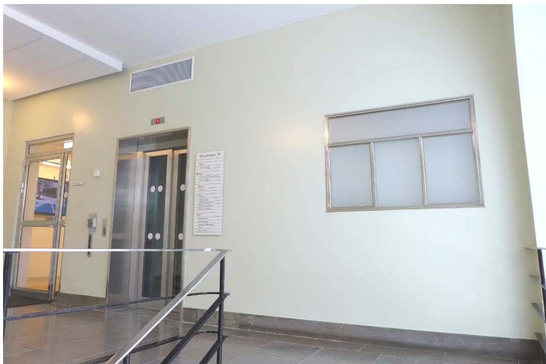
Luckan sedd från trapphuset 2015. Glasen hra en diffuserande film som är demonterbar.
