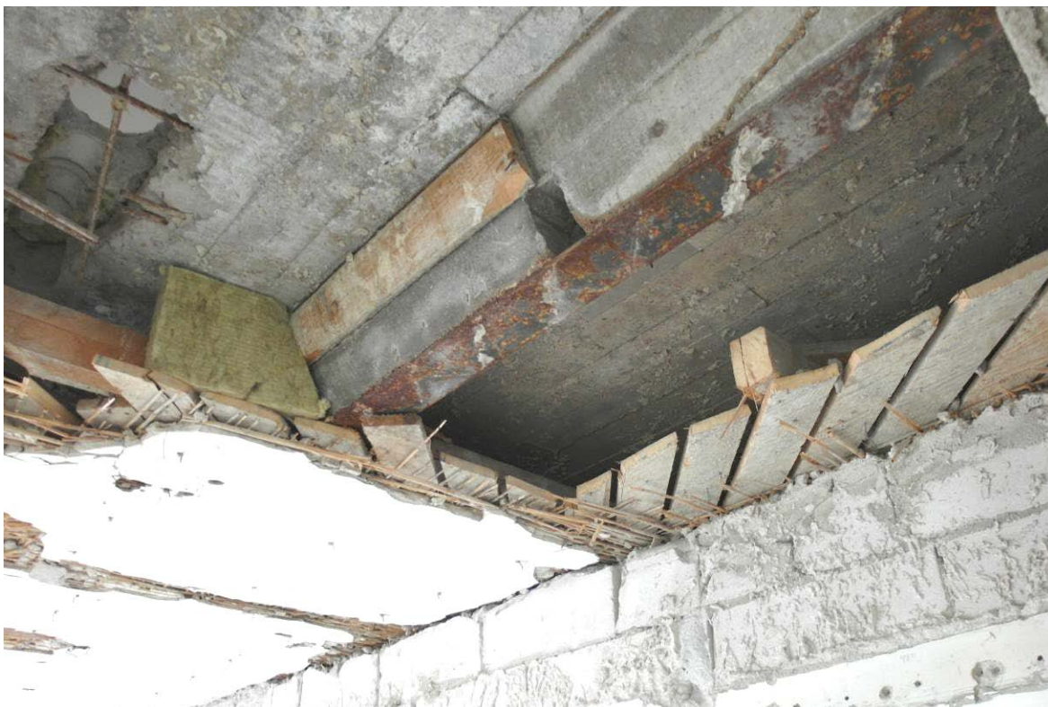
Under håltagningsarbeten mellan bjälklagen framkom stomkonstruktionen med bärande stålbjälkar med betongplatta samt en underliggande spräckpanel med vass och kalkputs
