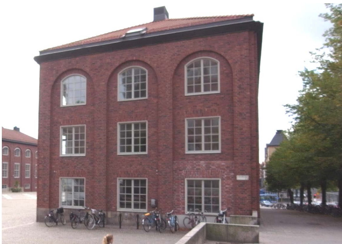
Gavelväggen före ombyggnad 2014. Takfönstret är idag igenlagd
