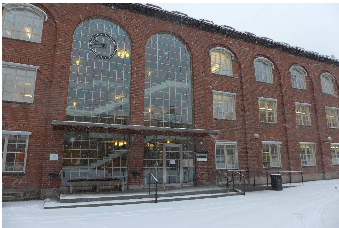
Entrén efter ombyggnad 2015. Bokstäverna som nu är rivna tillkom under sent 1900-tal.
