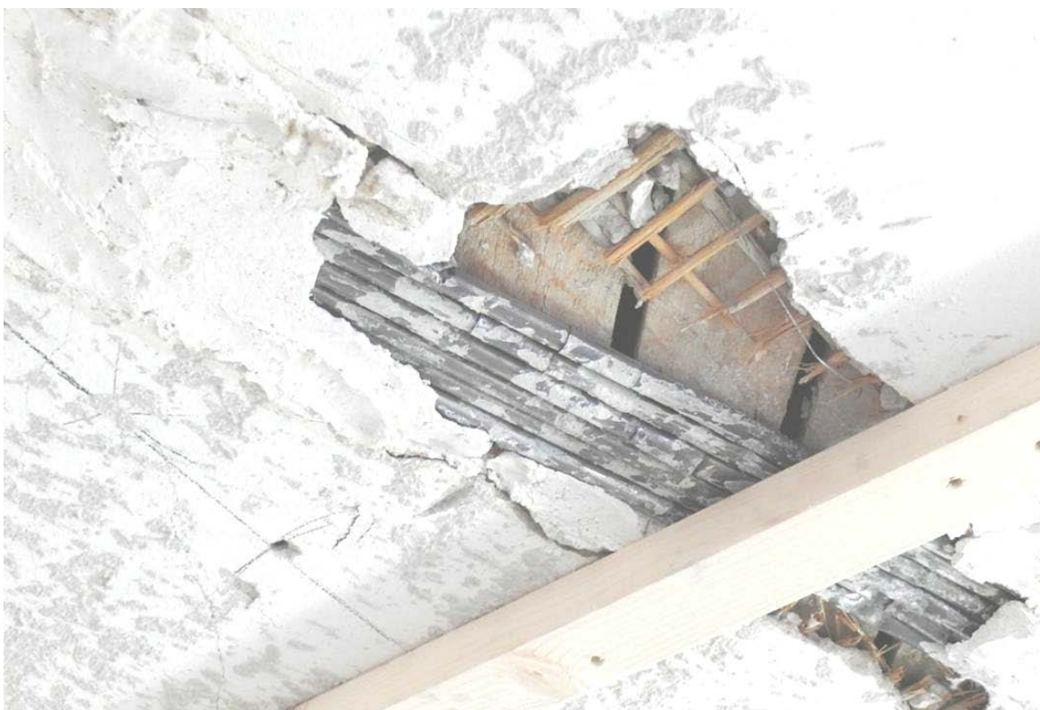
Elkablage senare tillkommet i blyrör, troligen från 1950-talets ombyggnad.
