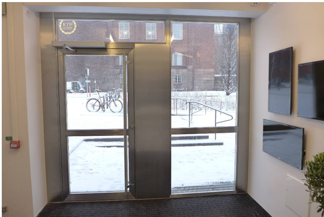
Nya entrén på norra gaveln från insidan
