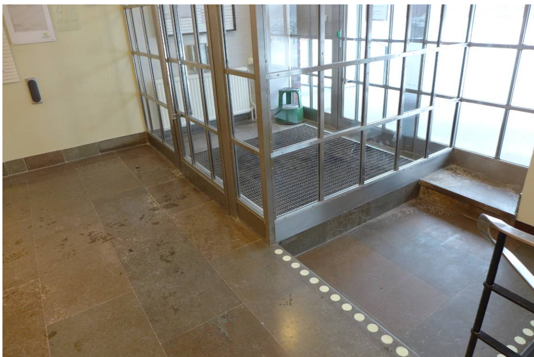
Golvytorna vid vindfånget är reparerade
