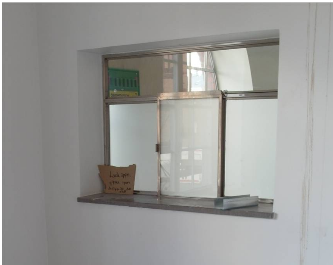
Luckan på plan 4 invid trappan sedd från bakomliggande rum. Luckan är idag igensatt på grund av brandskäl men synlig från trapphuset.
