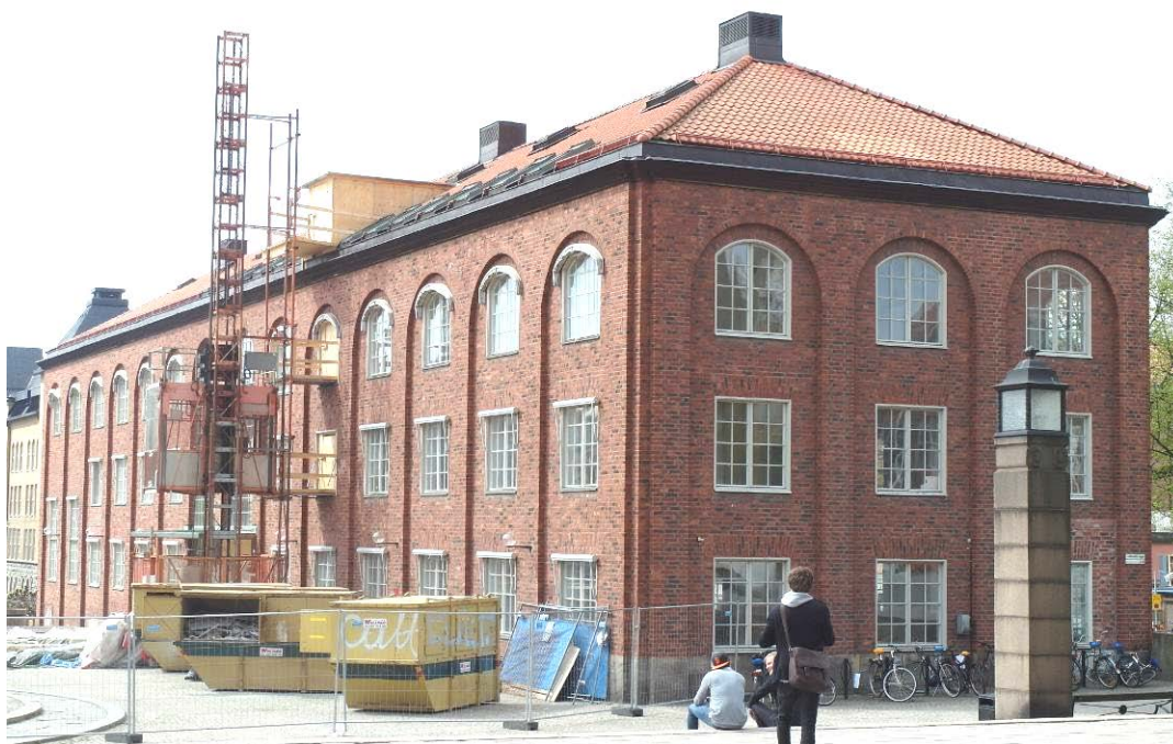
Byggnaden under arbete. Takfönstret på gavelfallet är igenlagd
