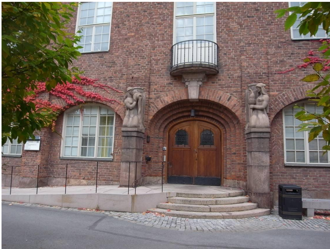
Huvudentrén mot gården med stenarbeten av granit. Rampen är tillkommen under 2000-talet. Notera att nischytorna kring fönstren har olika mönsermurning, detta gäller alla motsvarande ytor.
