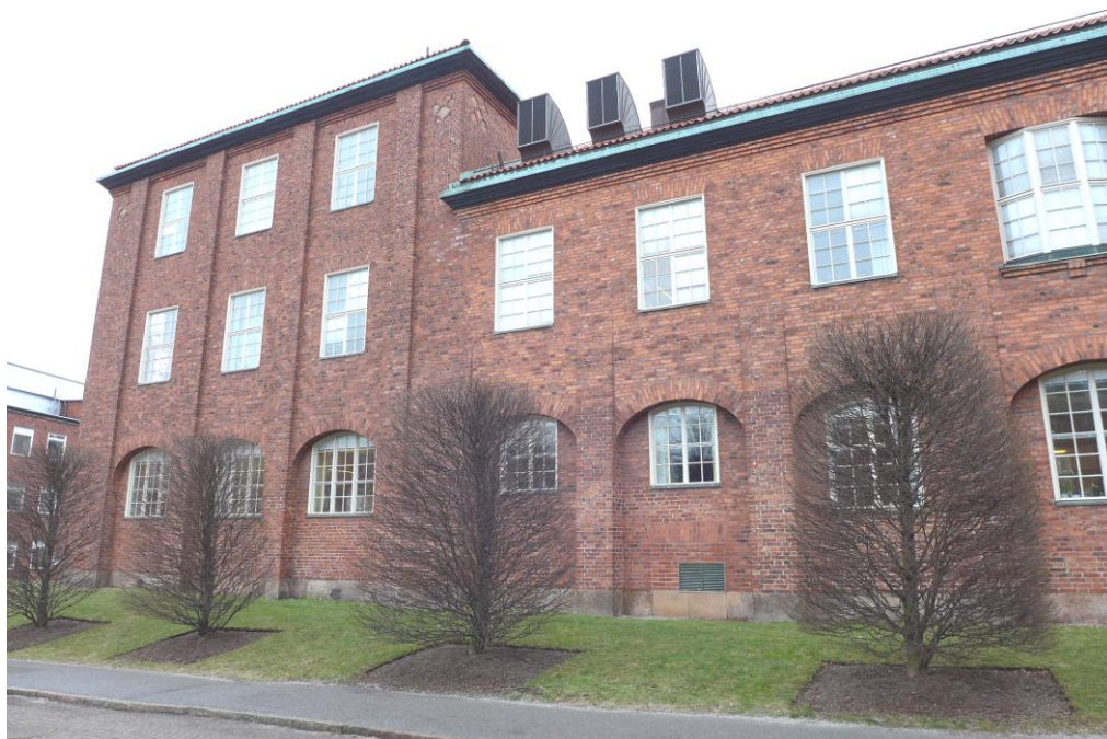
Del av fasad mot väster. Ventilationsdon på taket från ombyggnaden 1985-86.
