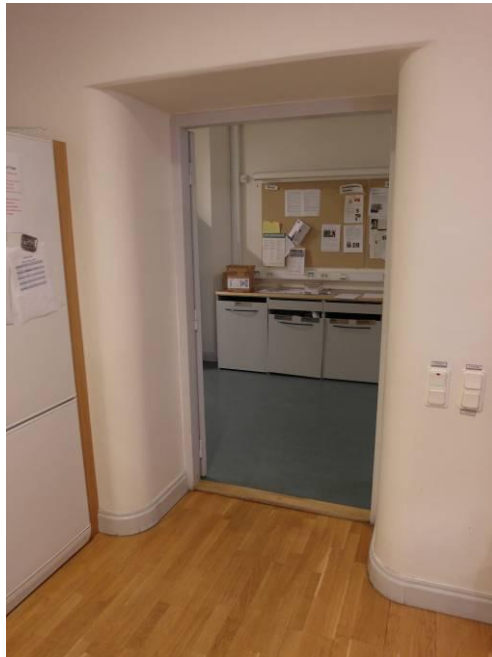
Muröppningar med svängda hörn utgör en karakteristisk detalj i ursprungliga dörröppningar.
