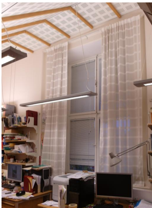
Invändiga undertak med trälistor från ombyggnaden 1985-86.
