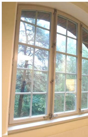
Fönster försedda med säkerhetsglas och polerade spanjoletter 2010, rum 581 m.fl.
