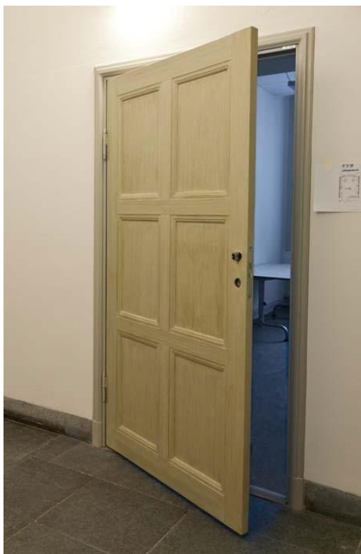
I korridor 530B ådringsmålades dörrbladens korridorsidor med linoljefärg i en gulgrå kulör i ett försök att efterlikna den ursprungliga ytbehandlingen.
