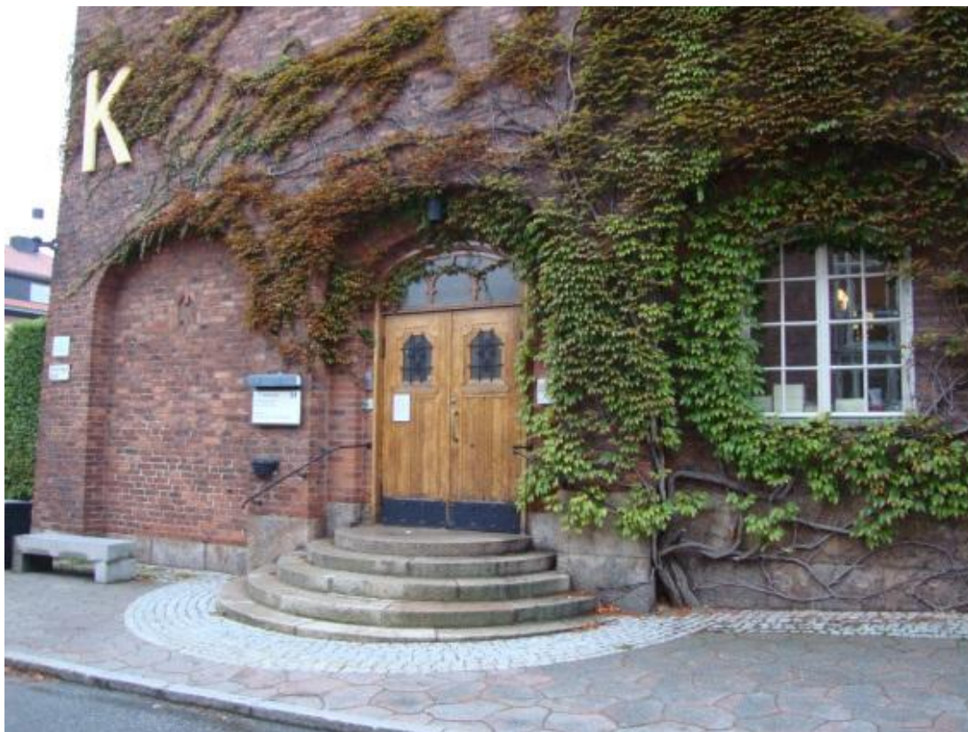
Entrén på norra flygeln är sannolikt flyttad från ett ursprungligt läge runt hörnet från gården.
