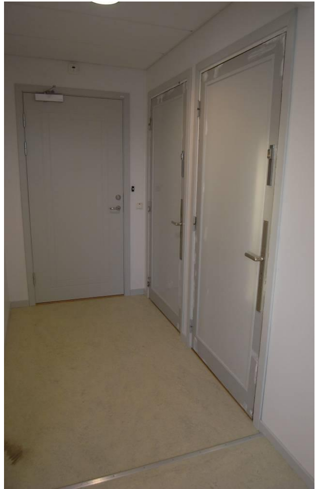
Ny lägenhetsdörr och två återanvända dörrblad
