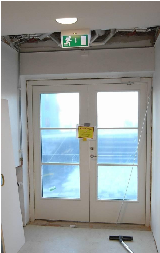
Ny utrymningsdörr på gaveln mot väster
